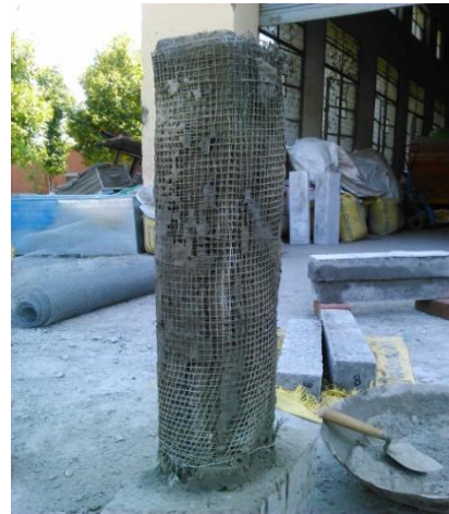
(d) Application of Cement Paste
