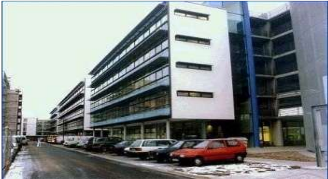
Fig 1.1: Vilbeler Weg office building ( www.b-i-m.de/projekte/projframe.htm )
