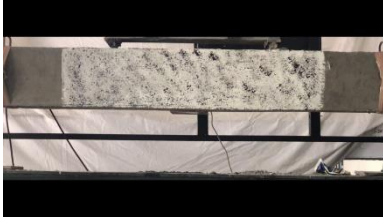
Actual Cracked Image
