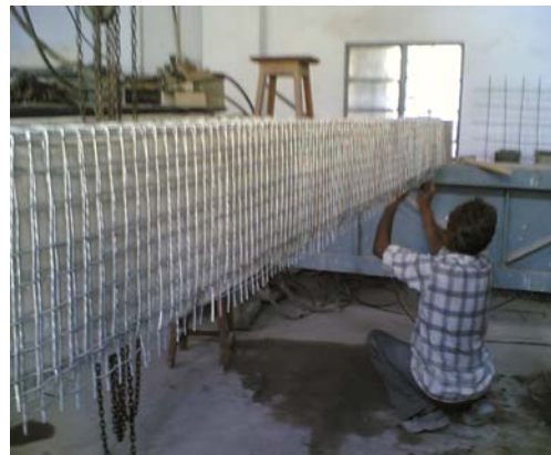
(d) Fixing of Wire Mesh - 2
