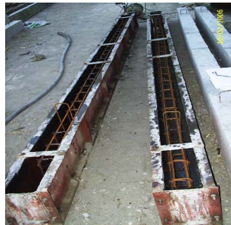
(d) Reinforcement Cage in Moulds
