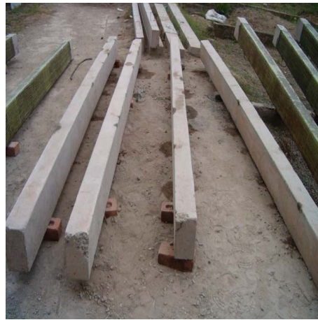
(d) Repaired Surface of the Beams
