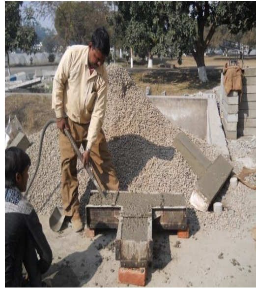
(d) Compaction of Concrete Using Needle Vibrator
