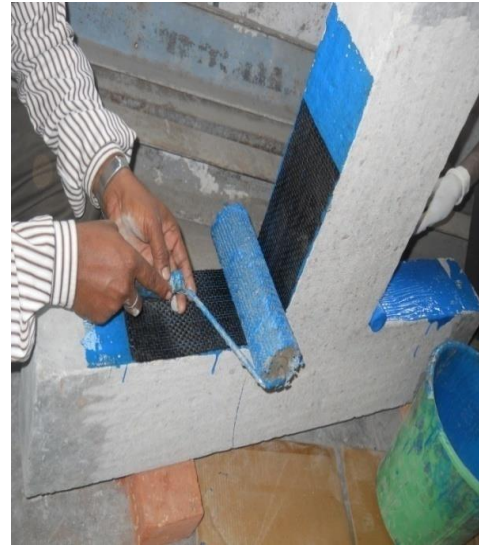
(d) Application of CFRP
