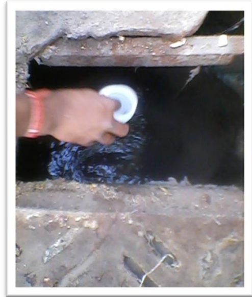
S1 Raw Effluent
